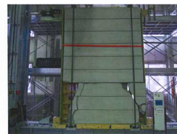
モルタルの剥落（瓦モルタル 2P-1）
