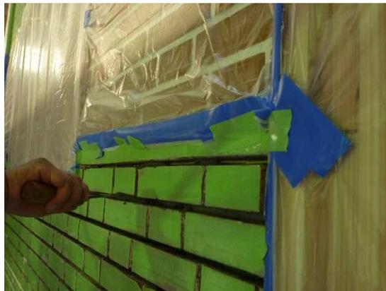
目地にアラミドロッド埋込みモルタル充填
