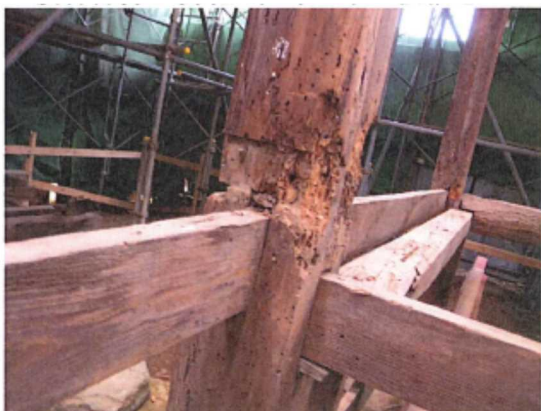
接合部分の劣化（二、と）：根継ぎ処理
