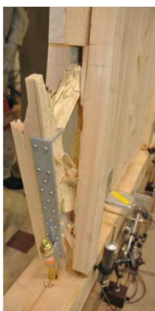
試験体③：柱脚 の破断
