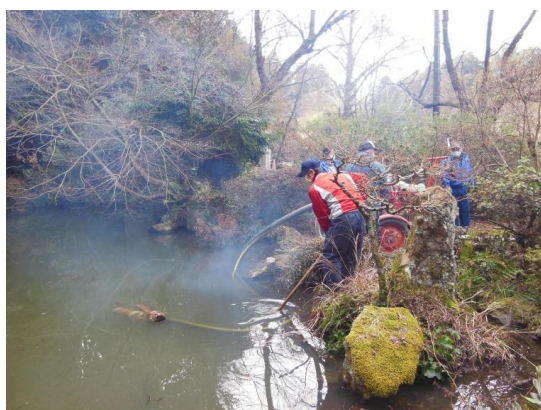
動力ポンプ給水作業
