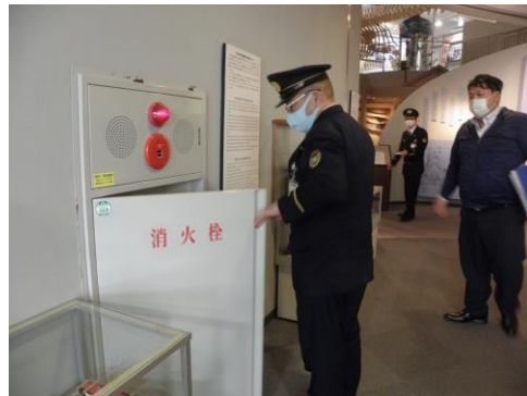
設備点検（博物館 島の館）
