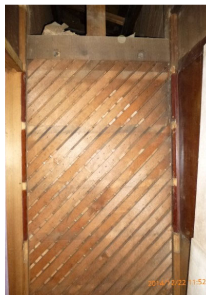
写真 1 斜格子木摺壁
