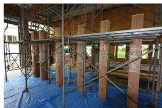
下部と中央を接着・養生
