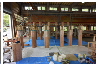
ロッドを挿入・接着・養生
