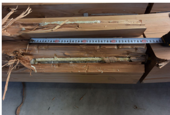
写真9 引き出されたロッドの状態
