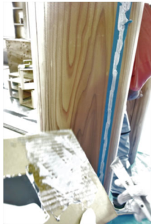
柱表面のシーリング
