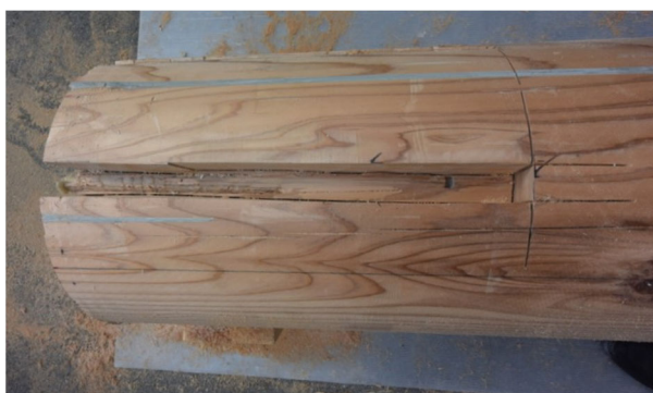
写真11 破損したアラミドロッドの状況
