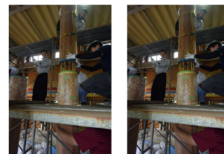
上部を吊上げ接着・養生
