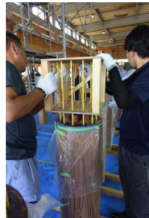
ロッドの挿入養生
