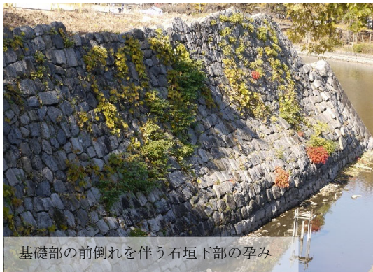
石垣基礎部の前倒れによる変状
