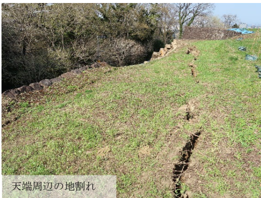
石垣天端の沈下
