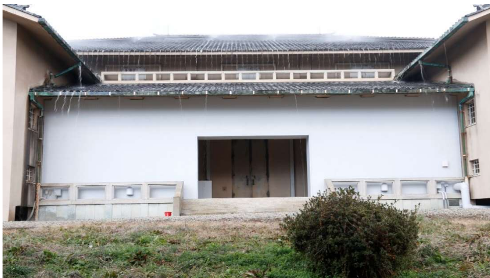
ドレンチャー放水
