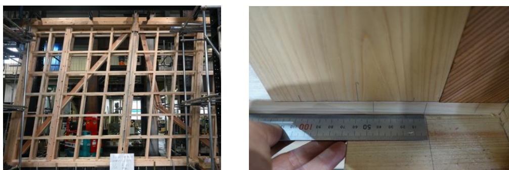
写真 4 破壊の様子 (試験体 4/C-1a) /左：終局時/右：1/50rad 時柱脚
