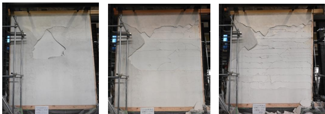
写真2 破壊の様子（試験体2/A-2）左：1/100rad時負側／中：1/50rad時／右終局時
