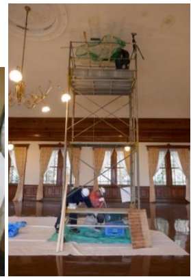
試験① (足場及び載荷状況)
