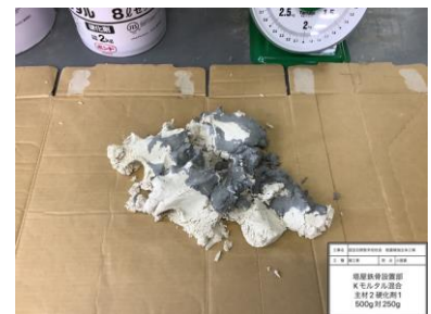
写真1 混合作業状態
