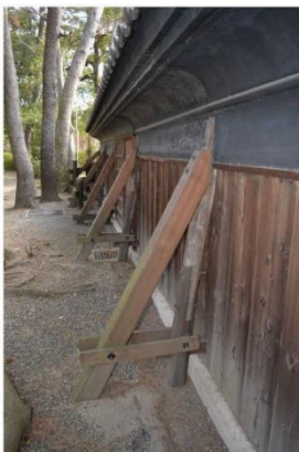
(参考) 指定外の塀への控柱追加及び基礎補強
