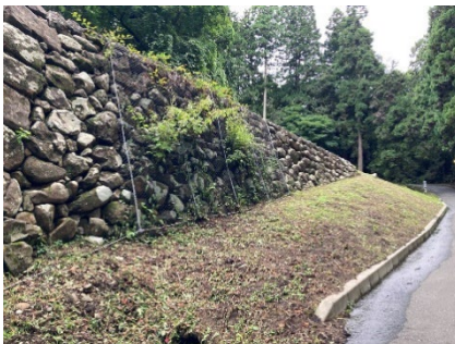
(参考) 石垣からの落石から、前面の園路を守る落石防止ネット
