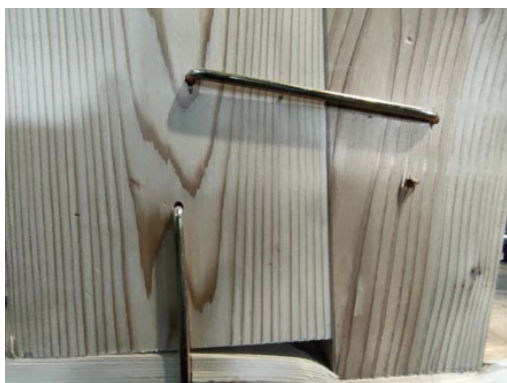
1-V 試験体 脚部 筋かいめり込み状況
