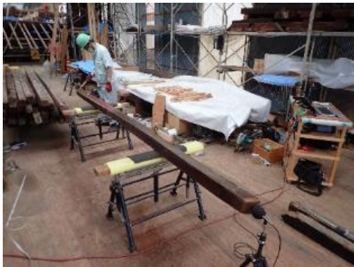
写真3 縦振動法によるヤング係数の測定
