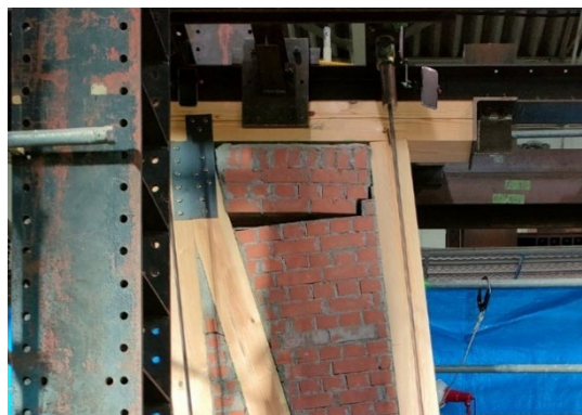
2-BV2 試験体 頂部 煉瓦離間状況
