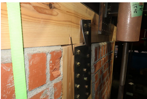
2-WBV 試験体 筋かい端部金物変形状況
