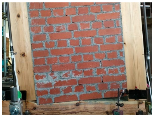
1-B 試験体 脚部 煉瓦めり込み状況
