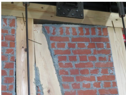
1-WBV 試験体 筋かい・煉瓦の離間状況
