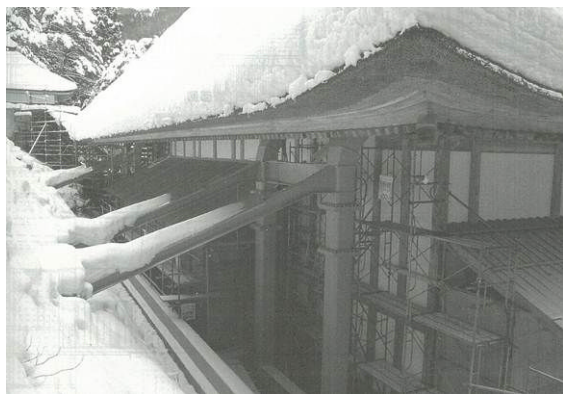
背面の鉄骨バットレス（①）
