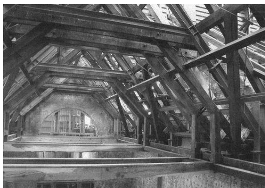
小屋組内の鉄骨トラス補強 (①)
