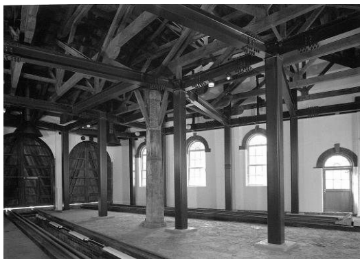
鉄骨フレーム補強（①）
