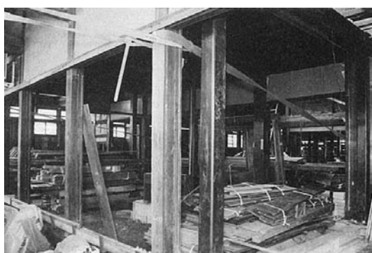
鉄骨フレーム補強 (①)
