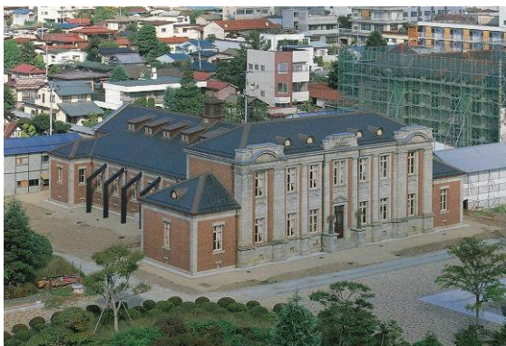
旧県会議事堂 外観
