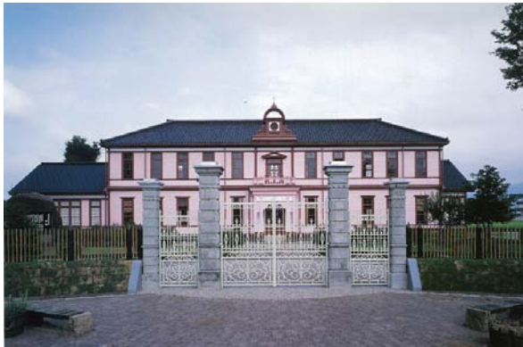
旧富山県立農学校本館 外観
