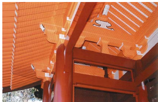
同左 内部見上げ
