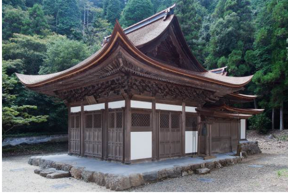
永保寺開山堂 外観
