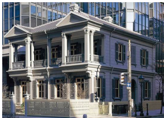
同左 修理後外観
