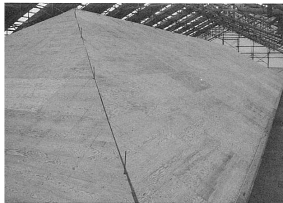
屋根野地面の構造用合板補強（④）
