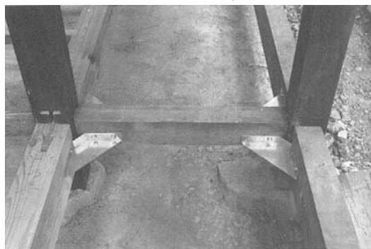
足固めの金物補強
