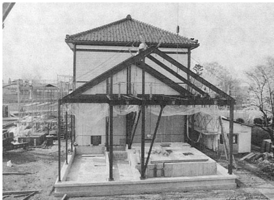
復原した教室棟による補強（①）
