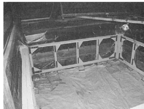
初層床下の鉄骨フレーム補強
