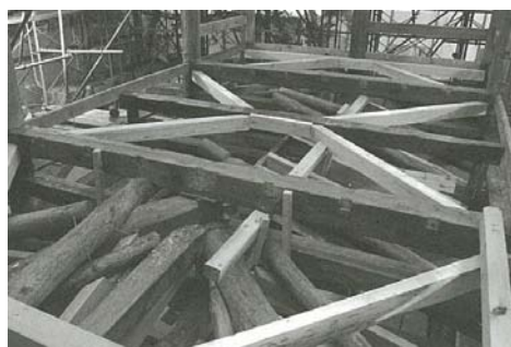
二層床下の火打ち梁
