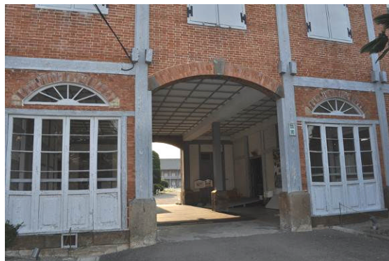
同左 1階中央通路
