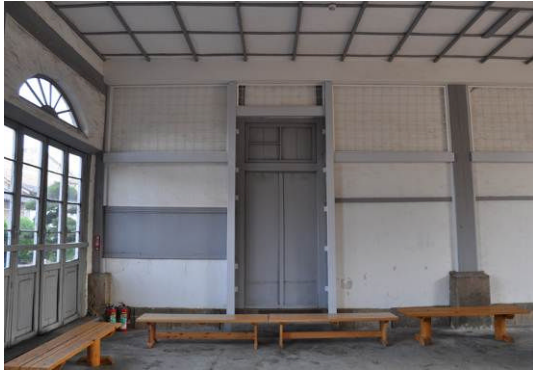
中央通路両脇の煉瓦落下防止補強（②）
