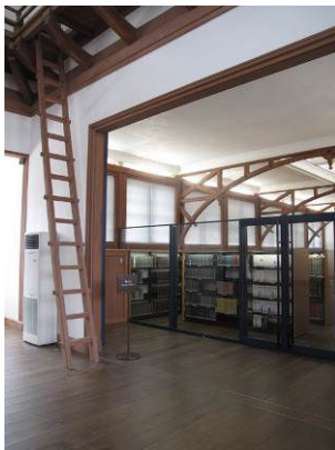
パーティションと鉄骨フレーム補強（①）
