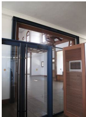
パーティションと鉄骨フレーム補強（①）
