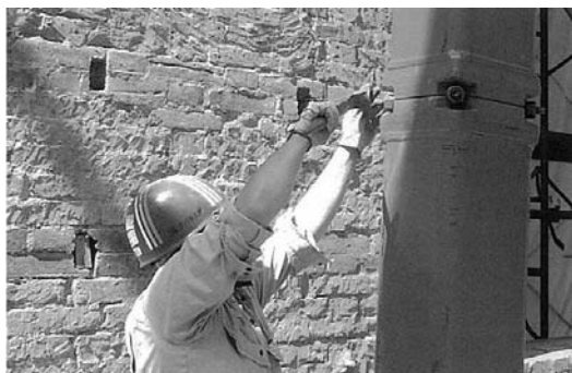
鉄骨柱の継手（③）
