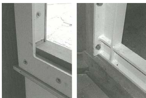
軸組内部の鉄骨フレーム補強
