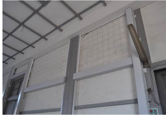
煉瓦落下防止補強詳細（②）
