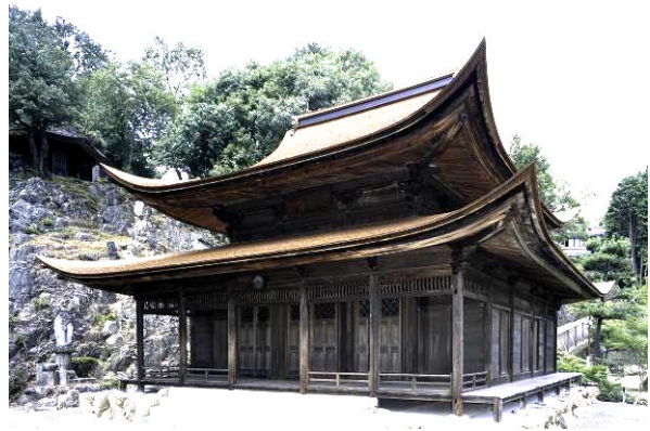
永保寺観音堂 外観
