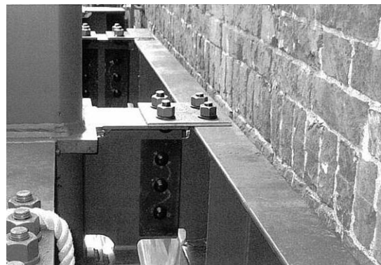
鉄骨フレームと煉瓦壁の取合い
