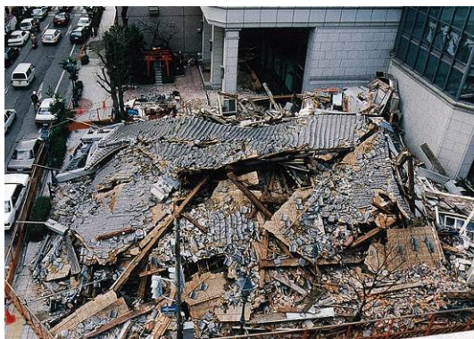
旧神戸居留地十五番館 被災状況
