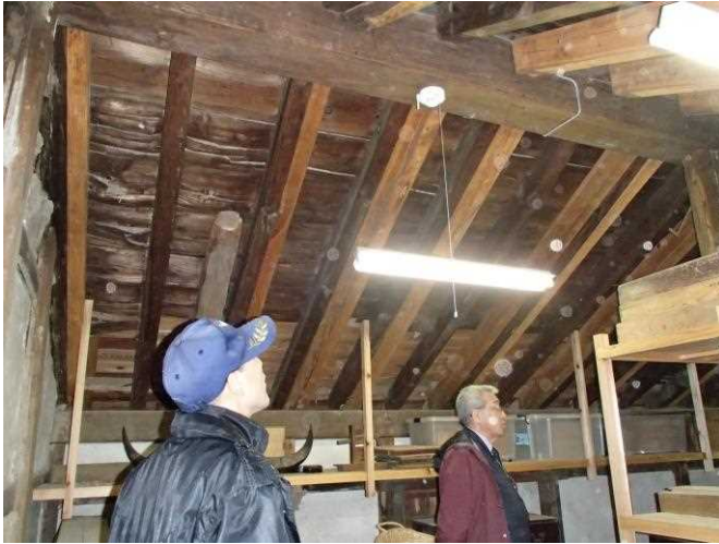
旧成器堂土蔵での防火査察 火災警報器点検
