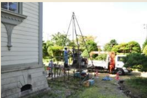
ボーリングによる地盤調査
