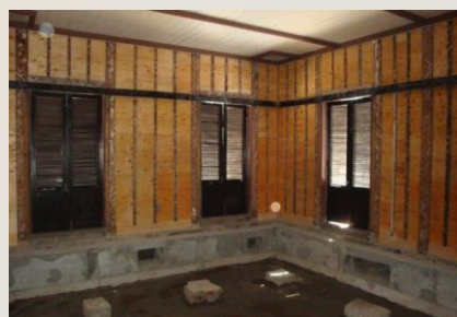
木格子による補強。小屋内の見えない位置に取り付ける。
