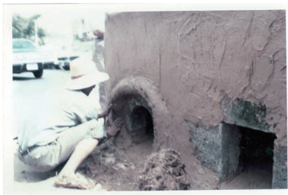
写真 128 唐釜製造工程⑱
