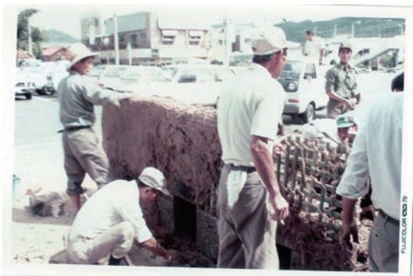
写真 118 唐釜製造工程⑨
