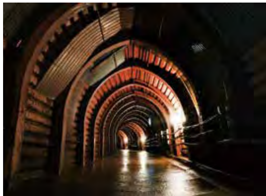
生野鉱山坑道内（朝来市）
