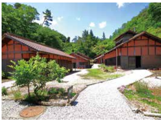
整備された旧弁柄工場（ベンガラ館）
