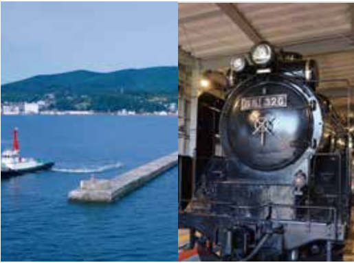
小樽港北防波堤(小樽市)
