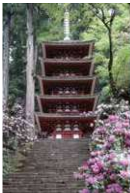
室生寺の五重塔
