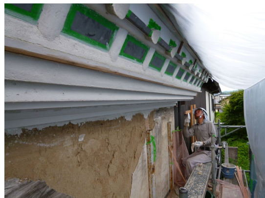
清野家の修理の様子
