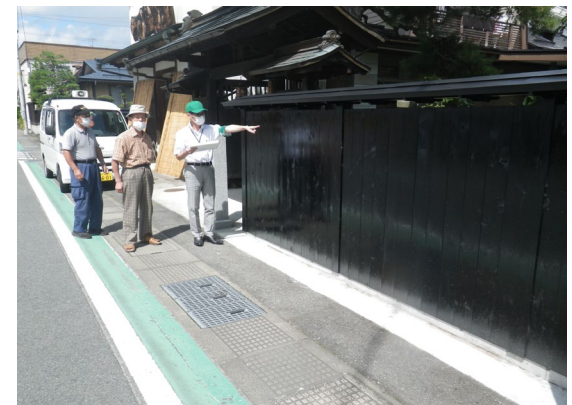
富士屋（岡田家）の塀の修理後の様子
