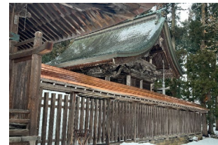
補助金を活用した整備（神社瑞垣屋根修理）
