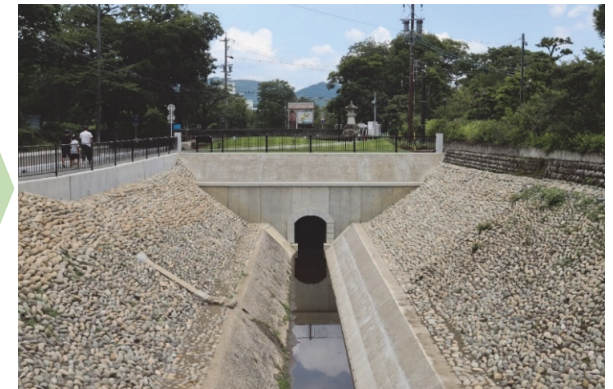
忠節用水（整備後）
