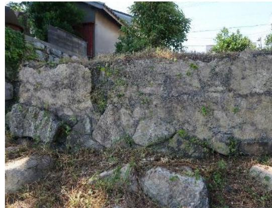
崩落とモルタル補強が見られる石積み
