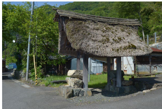
東の四足門（修理前）
