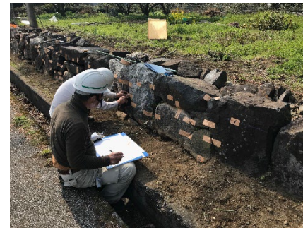
構成要素である石垣の復旧作業
