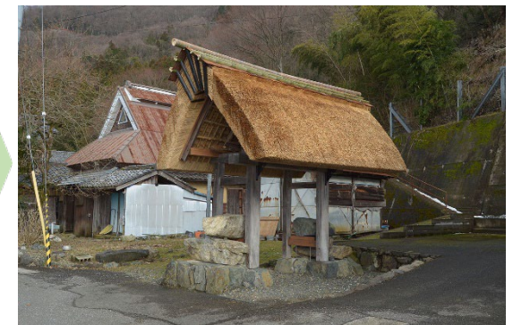
東の四足門（修理完了後）
