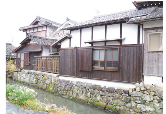
正厳寺書院 修理後（令和3年度）
