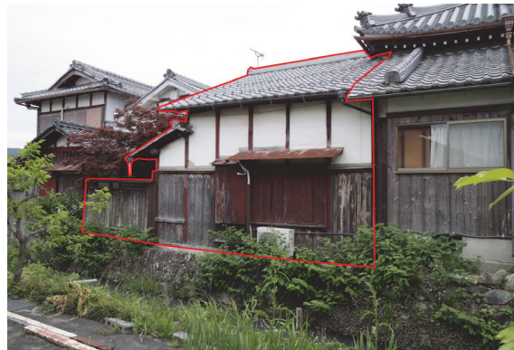
正厳寺書院 修理前
