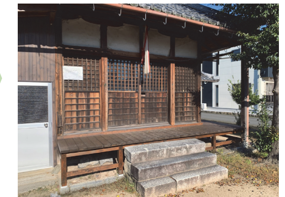
薬師堂縁 修理後（令和元年度）
