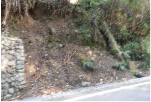
自然災害により法面が崩落
