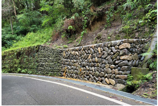
玉石練積みでの石積みを行い法面を修繕
