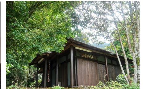
改修工事後の毘沙門堂
