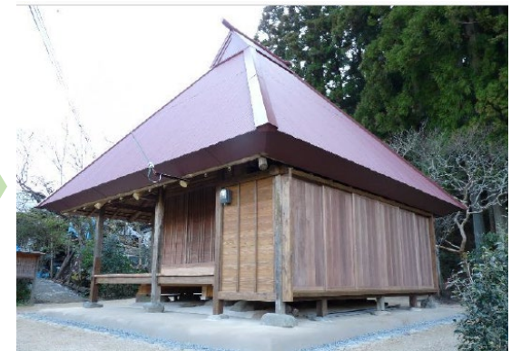
修理後。耐震性、利便性も向上（平成29年3月竣工）
