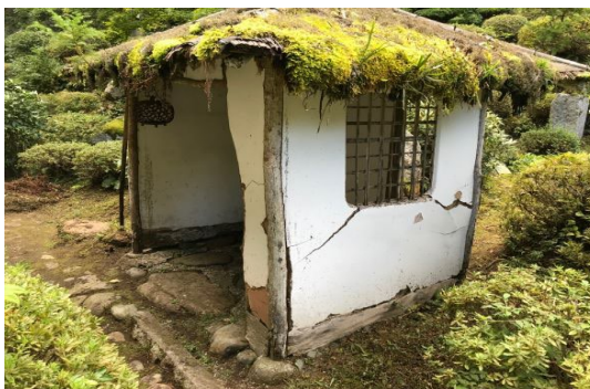
倒壊しそうになっていた絲原家住宅茶室待合
