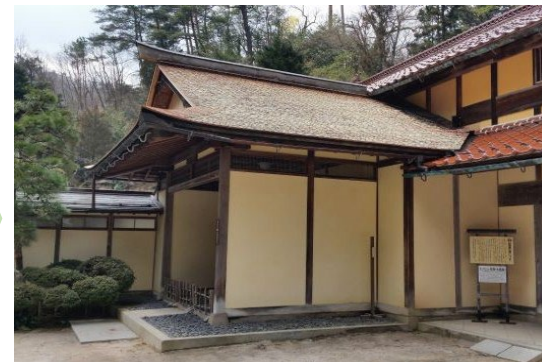
修理事業によって保存修理された柿葺き屋根
