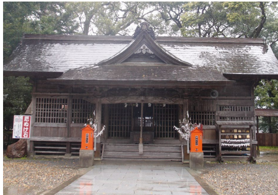
久礼八幡宮（屋根葺き替え前）
