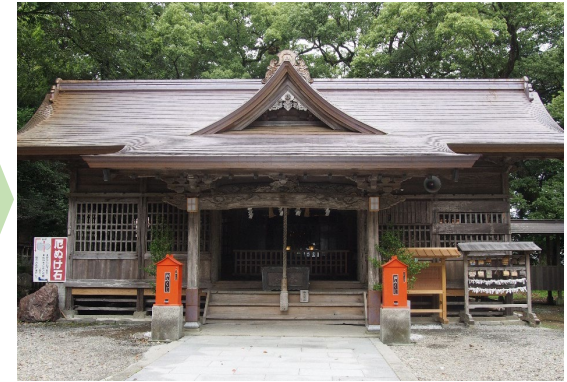
久礼八幡宮（屋根葺き替え後）
