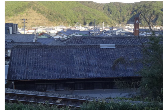
修理中の西岡酒造酒蔵屋根（手前から二棟目）
