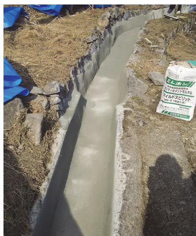
無収縮モルタルによる水路の補修
