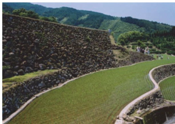
高さ8.5mの高石垣（南川原）
