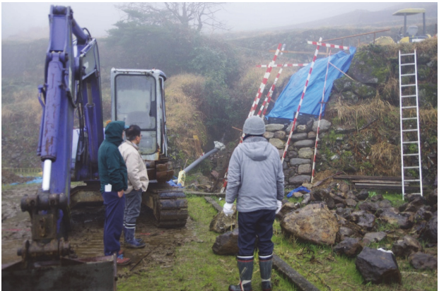
石積みの修理
