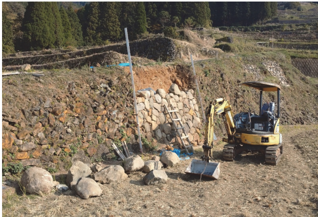
石積みの災害復旧
