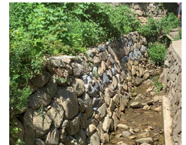
景観に配慮した災害復旧工事
