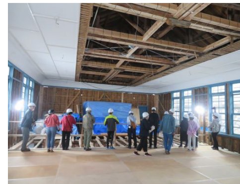
龍驤館の耐震補強工事見学会
