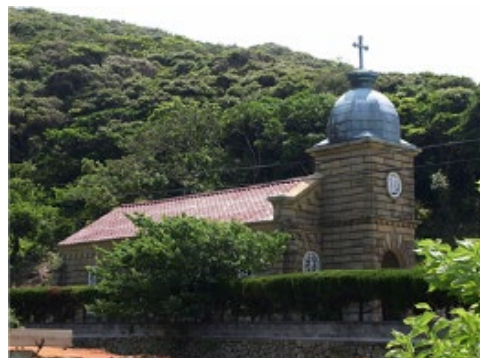
幕末に潜伏キリシタンの移住があった頭ヶ島集落に 禁令解除後に築かれた頭ヶ島天主堂
