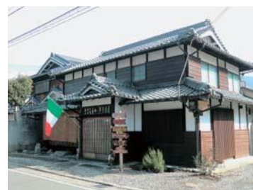
空き家活用事例 「薪窯ピッツァ LaMiaCasa」
