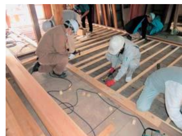
空き家の再生
