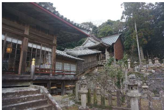
写真 60 亀岡神社本殿・登廊
