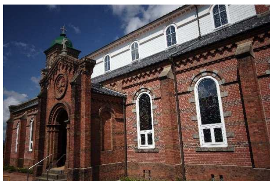
写真 69 田平天主堂（国指定建造物）
