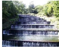
奥沢水源池水道施設「階段式溢流路(水すだれ)」(大正3年造)
