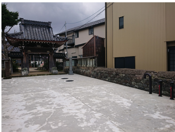
図 8-6 金沢市寺町台における寺院参道の敷地を利用した防火水槽の設置（金沢市提供）
