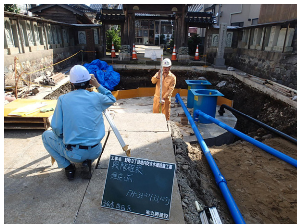
図 8-6 金沢市寺町台における寺院参道の敷地を利用した防火水槽の設置（金沢市提供）
