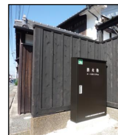
防災施設整備
