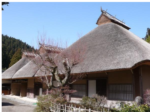
国指定重要文化財 平川家住宅(一般公開) 18世紀後期に建てられた凹型寄棟造の茅葺住宅
