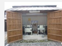
ポンプ格納庫
