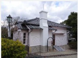
耐震補強:旧ウォーカー住宅
