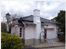
耐震補強:旧ウォーカー住宅
