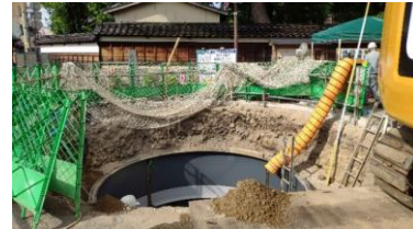
防火水槽工事中
