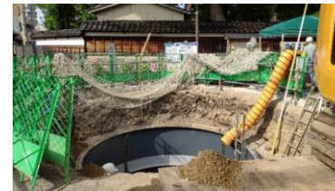
防火水槽工事中
